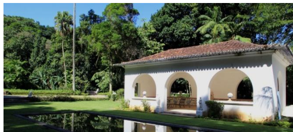
Figura 5: fachada Museu do Açude. Fonte: foto de divulgação 57 .
